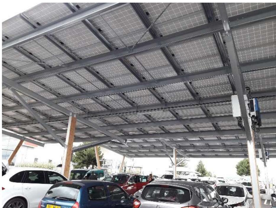
Figure 5 : Positionnement des onduleurs
