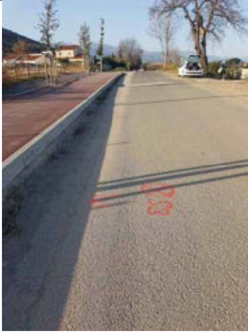
Environnement sondage S3
