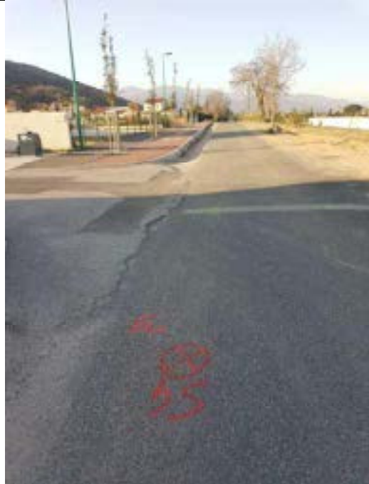
Environnement sondage S4
