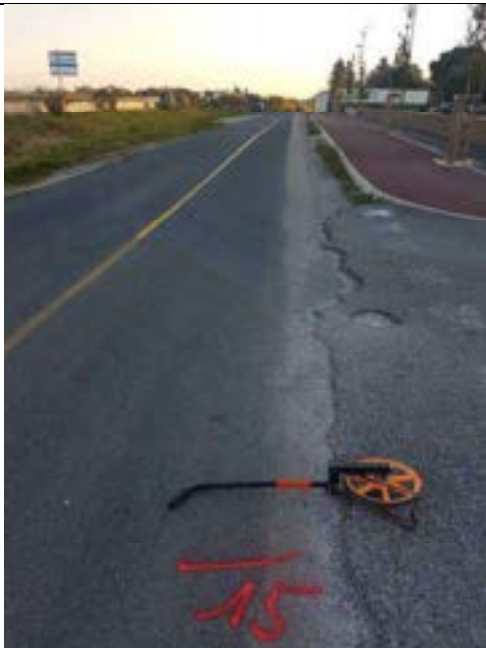
Environnement sondage S5
