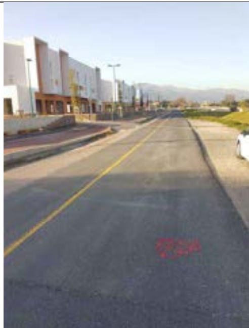
Environnement sondage S6
