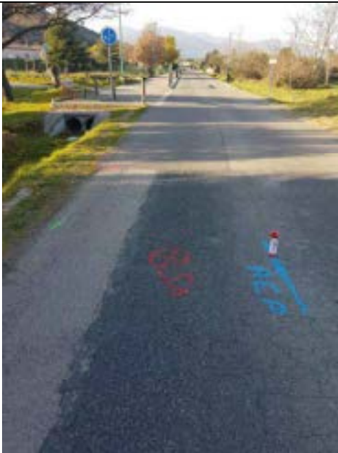
Environnement sondage S1
