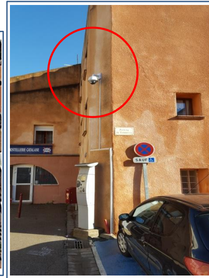
Fixation sur bâtiment
