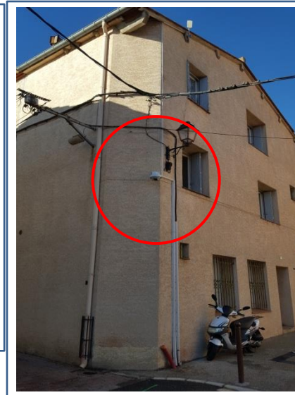
Fixation sur bâtiment
