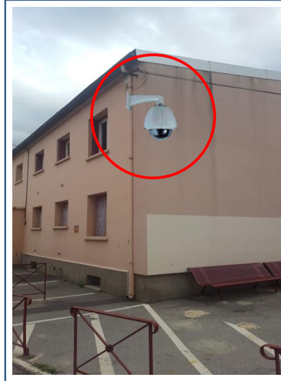
Fixation sur bâtiment
