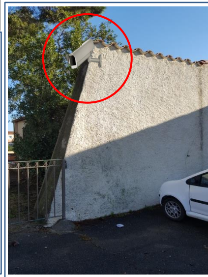
Fixation sur bâtiment
