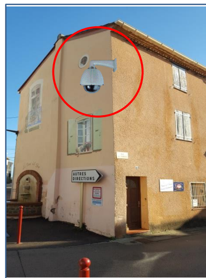
Fixation sur bâtiment
